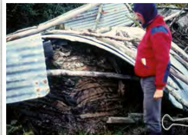
Figura 6. Galpón de acopio de pieles, Tethis.
