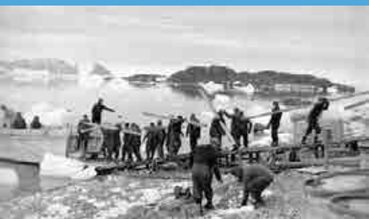
Figura 2: Instalación de la Base Gral. San Martín, marzo de 1951 (Archivo General de la Nación).
