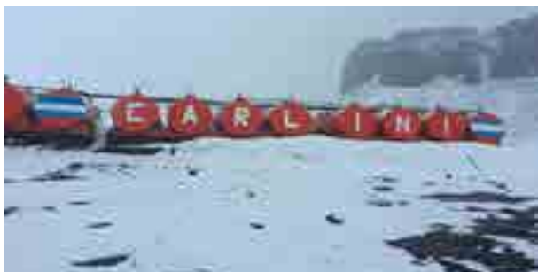
Figura 1: Tanques de almacenamiento de combustible en la Base Carlini.
